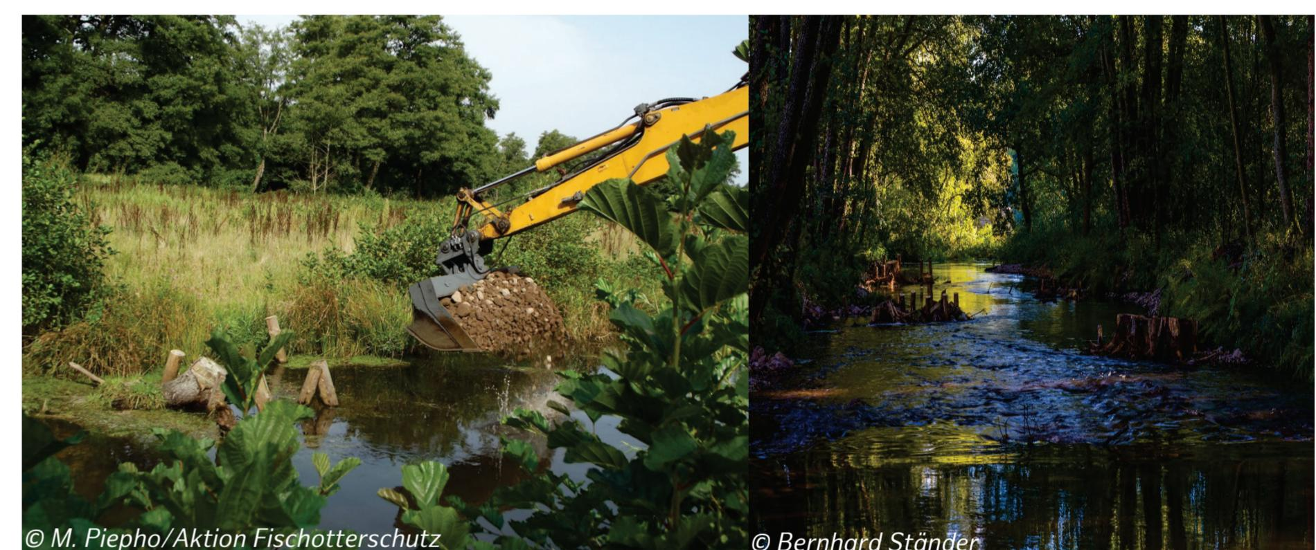
An der Luhe (links, LK Harburg) wurde ein naturnaher Nebenarm durch Kiesschüttungen eingeengt – die höhere Strömungsgeschwindigkeit verhindert ein Versanden des wertvollen Biotops. An der Seeve (rechts, LK Harburg) wurde durch das einbringen von Totholz, Kies und Lesesteinen die Strömungsvielfalt und die Gewässerstruktur deutlich erhöht.
