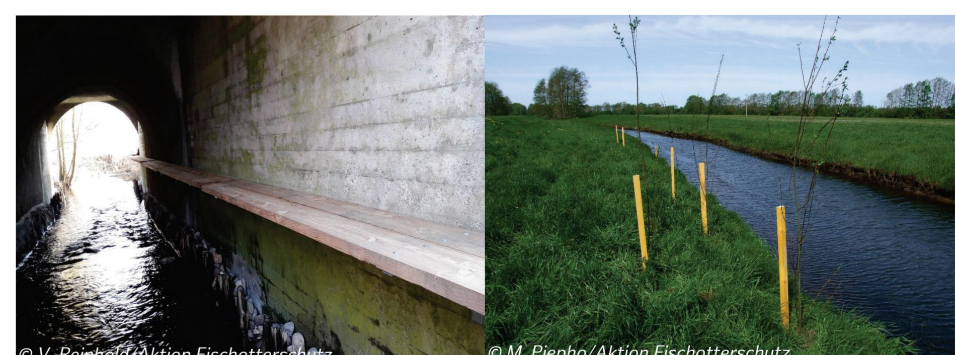
Die Brücke an der Schwartau (links, Kreis Ostholstein) wurde mit einer Otterberme ausgestattet, welche den Tieren ein gefahrloses unterqueren der Straße ermöglicht. An der stark begradigten Rögnitz (rechts, LK Ludwigslust-Parchim) wurden Weiden und Erlen gepflanzt, welche die Uferstruktur aufwerten.
